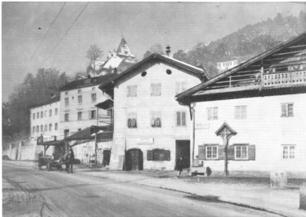
Die westlichste der einstigen Huf- und Wagenschmieden an der Haller Straße knapp unterhalb der alten Auffahrt bzw. an der Stelle der jetzigen Auffahrt der Anton-Rauch-Straße. (Stadtarchiv Innsbruck, Photosammlung. Repro auf Seite 1801 von Margarete Hye)
